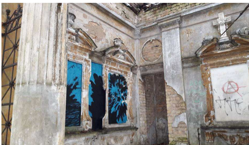
4. attēls. Nicolai Pychlau dzimtas kapliča. Zudušā jumta rezultātā ir bojāts celtnes mūris un tiek zaudēta celtnes unikālā dekoratīvā apdare, vandālisma rezultātā tiek bojātas baltajā marmorā kaltās apdares plāksnes, 2016. gada foto attēls.
