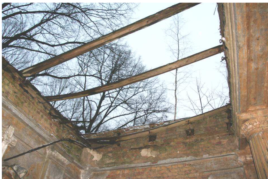
3. attēls. Nicolai Pychlau dzimtas kapliča. Zudis kapličas jumta segums, zudušas nesošās jumta konstrukcijas, lietus un sala iedarbībā bojātas celtnes nesošās konstrukcijas, 2016. gada foto attēls.
